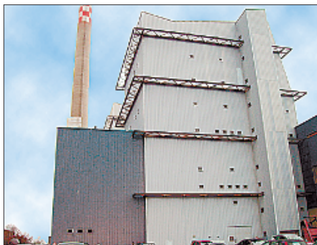
Bestehendes Gaskraftwerk Chavalon. Foto wb
